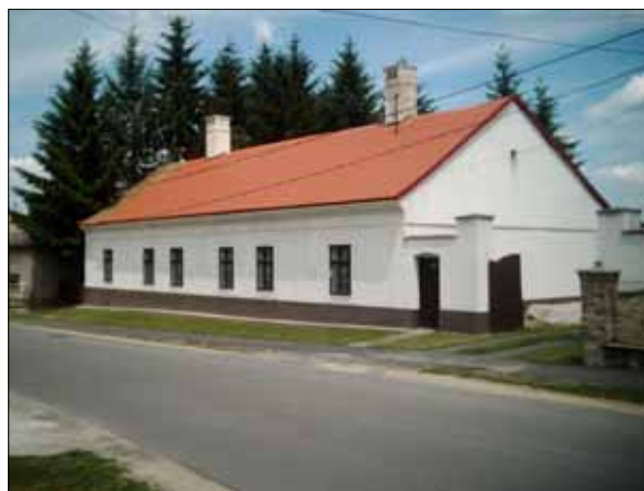
Az új lécezésre utcafrontra került az új cserép Neues Dach am Pfarrerhaus
