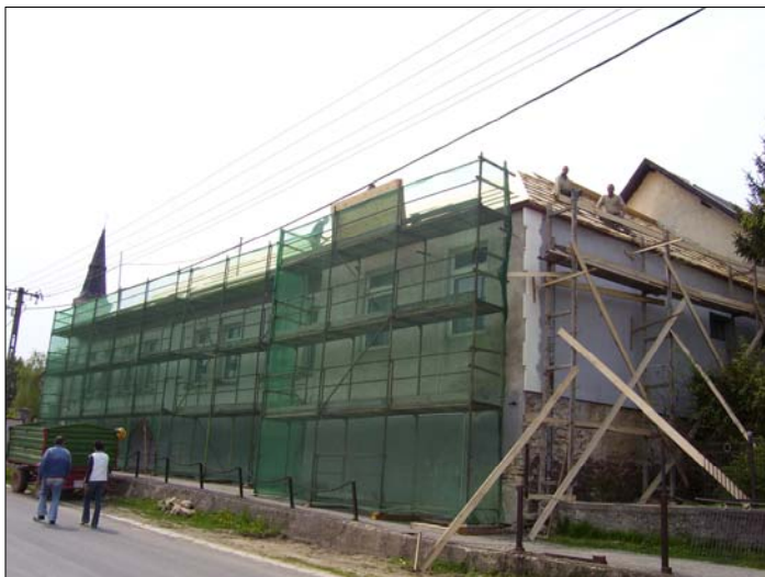
A felújítást követően esztétikailag is megszépül az épület Renovierung der Schule
