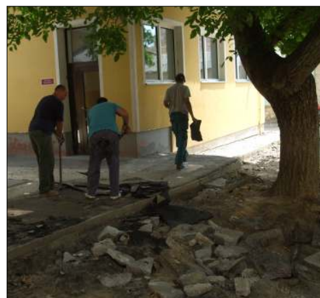
Az iskolaudvar térkövezésének kezdete
